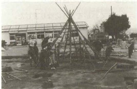
第 4 図 屋根の骨組みをつくる
