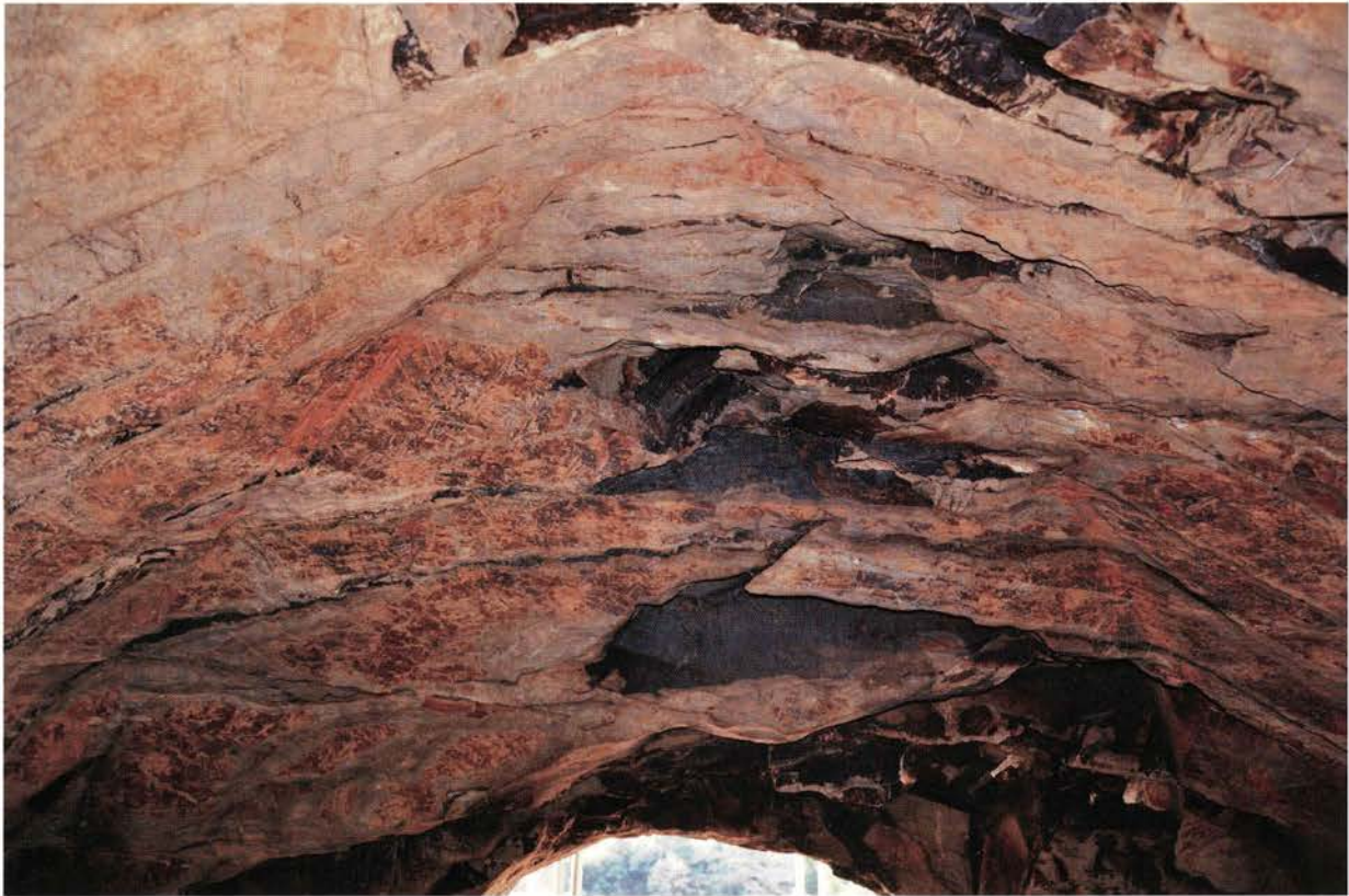
天井は四隅に稜をもつ家形をしています。
