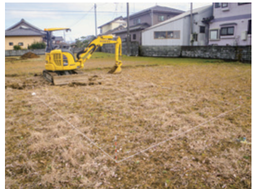
トレンチ掘削状況 (金山遺跡)
