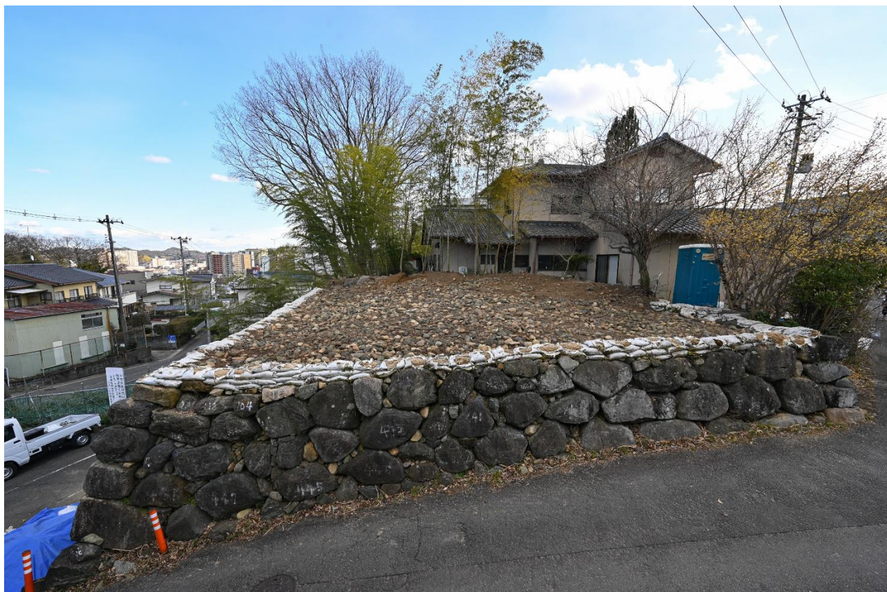
磐城平城塗師櫓 現況確認調査前全景 福島県いわき市平字旧城跡地内
