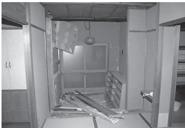
東日本大震災による被害状況 (生涯学習プラザ)
