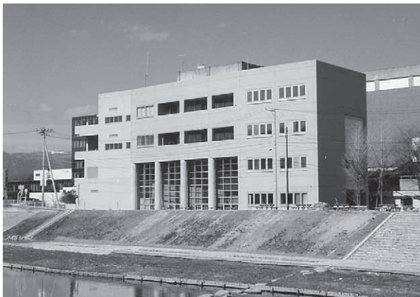
いわき市音楽館外観 (いわき市平字三崎)
